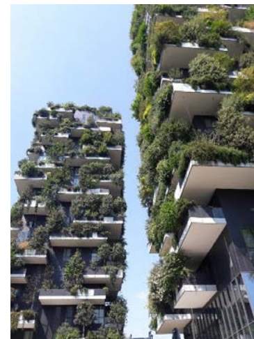
Abbildung 15: Begrünte Fassaden und Balkone tragen zum Erholungswert und angenehmerem Klima bei
